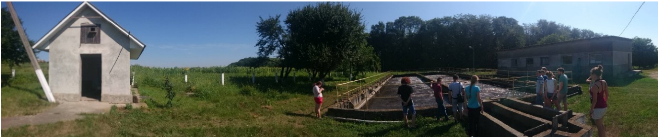
Abbildung 35: Eine kleine Kläranlage im Privatbetrieb
