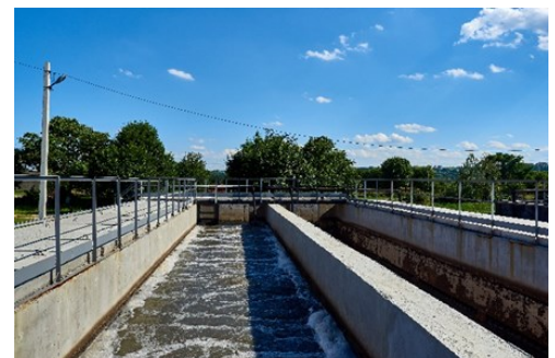
Abbildung 8: Spülung des Wassers mit Sauerstoff
