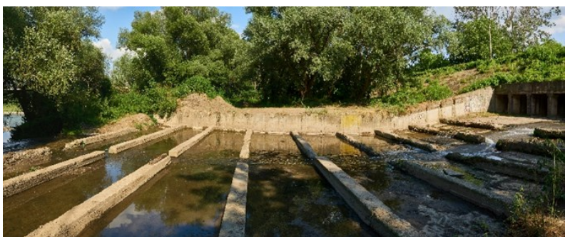
Abbildung 18: Ein mechanisches Filtersystem aus Betonblöcken vor der Flussmündung
